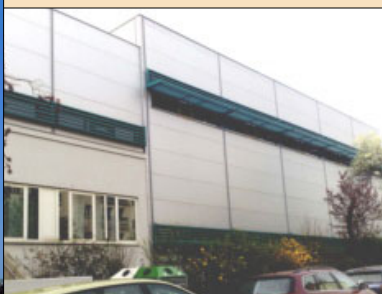
Goethe Gymnasium Turnhalle
